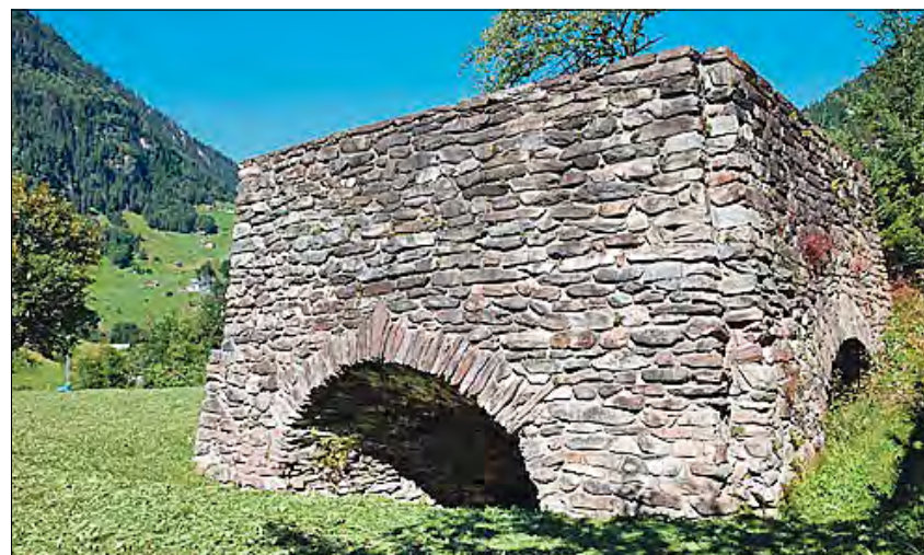
Der 1966 restaurierte Schmelzofen bei der Talstation der Seilbahn Golzern soll für eine eindrückliche Kulisse anlässlich des Freilichttheaters «Madrano» im Jahr 2020 sorgen. FOTO: ZVG
